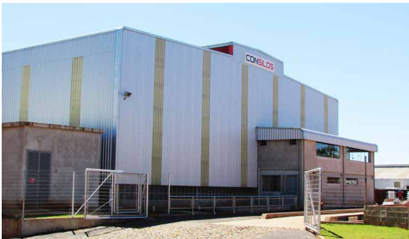
Unidade Consilos Industrial de Galvanização a fogo
